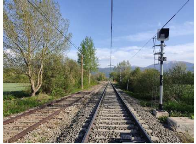
Imatge 4.14. Doble via al tram entre la Tor de Querol – Enveig i Puigcerdà, amb via d'ample estàndard (a l'esquerra, en desús) i via d'ample ibèric (a la dreta)
