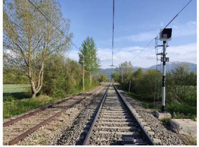
Imagen 4.14. Doble vía en el tramo entre la Tor de Querol – Enveig y Puigcerdà, con vía de ancho estándar (en la izquierda, en desuso) y vía de ancho ibérico (en la derecha)
